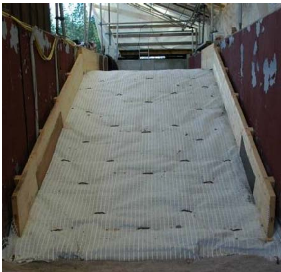
Abbildung 4.2-4 Versuch 11 vor/nach Überströmung
