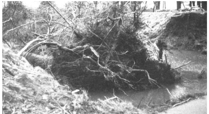
Abb. 1: Deichbruch durch einen umgestürzten Baum auf einem Elbedeich bei Harburg aus EDER 2002
