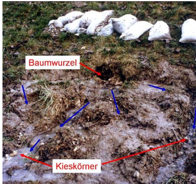
Abb. 3: An abgestorbener Baumwurzel ausgetragene Kieskörner (Quelle: WWA Deggendorf)
