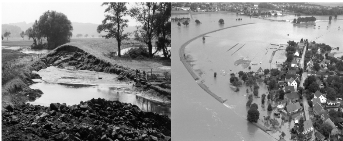
Abb. 1: Über 100 Deichbrüche und Überflutungen an der Mulde im August 2002 (HEERTEN & HORLACHER, 2002)
