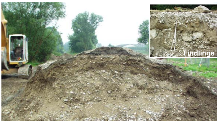
Bild 1: Aufgegrabener Deich an der Mangfall (Quelle: WWA Rosenheim, aus [1]).
