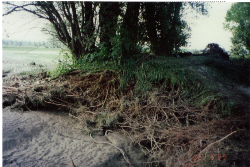
Abbildung 1: Deichbruch an der Ammer bei Pschorn während Hochwasser 1999 (Quelle: WWA Weilheim, Bayern) – Deichmaterial von Wurzeln durchörtert und verdrängt (aus Haselsteiner & Strobl, 2006)
