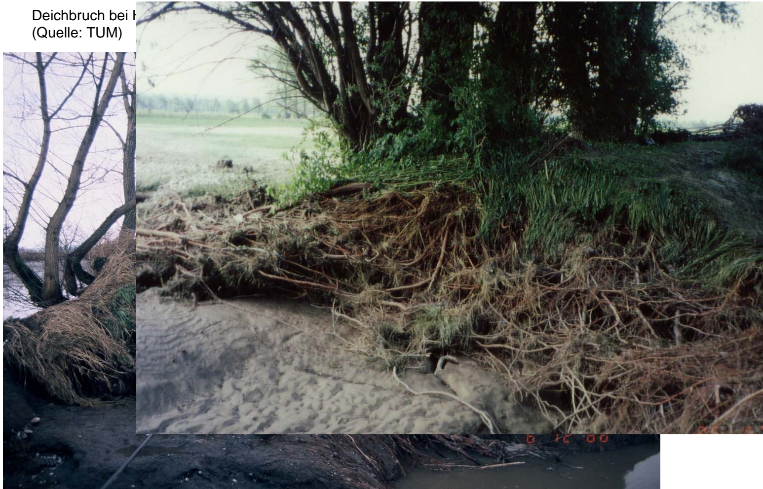
Deichbruch an der Ammer während Hochwasser 1999 (Quelle: WWA Weilheim)
