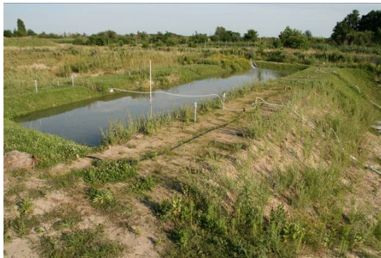
Abbildung 2: Becken im eingestauten Zustand während eines Durchsickerungsversuches (Deutsch-Wagram, 18.06.2008)
