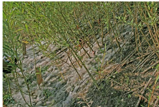
Abbildung 5: Überströmung der Weidenspreitlage-längs (Deutsch-Wagram, 19.06.2008).
