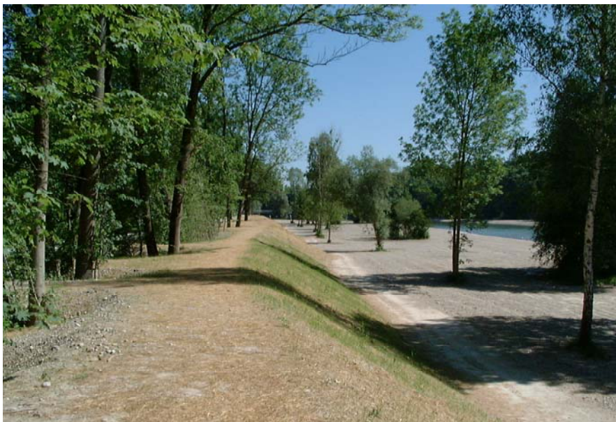
Abb. 2: Ertüchtigter Isardeich im Stadtbereich München mit verbleibendem Gehölzbewuchs (Quelle: WWA München)
