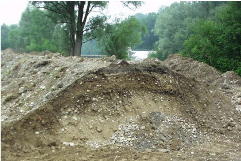
Abb. 1: Inhomogener Querschnitt eines Deiches an der Mangfall im Bereich von Bad Aibling (Quelle: WWA Rosenheim)
