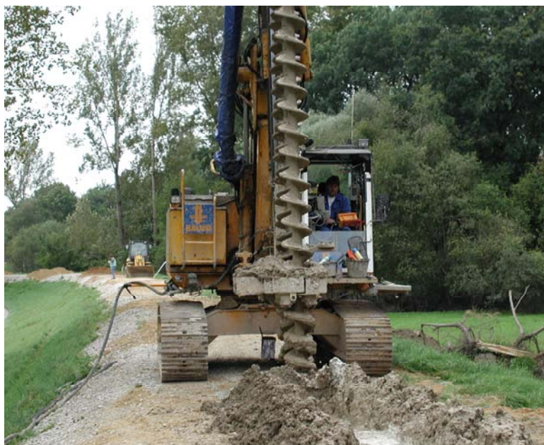
Abb. 3: MIP-Wand-Einbau an einem Deich an der „Kleinen Donau“ (Quelle: WWA Ingolstadt)
