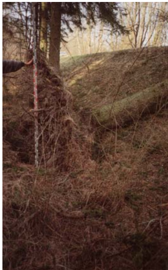
Abb. 5: Entwurzelte Fichte am Fuß eines Lechdeiches (aus LfW BY 1990)
