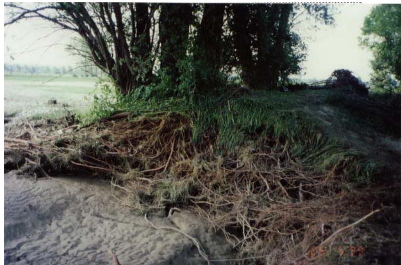
Abb. 1: Deichbruch während HW 1999 an der Ammer bei Pschorn (Quelle: WWA Weilheim)
