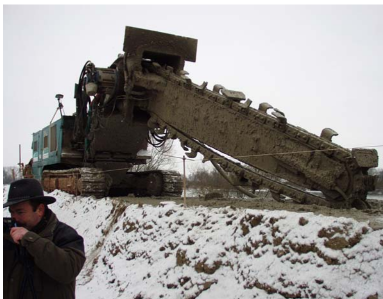
Abb. 4: FMI-Wand-Einbau an einem Deich bei Niederaltich an der Donau (Quelle: TU München)
