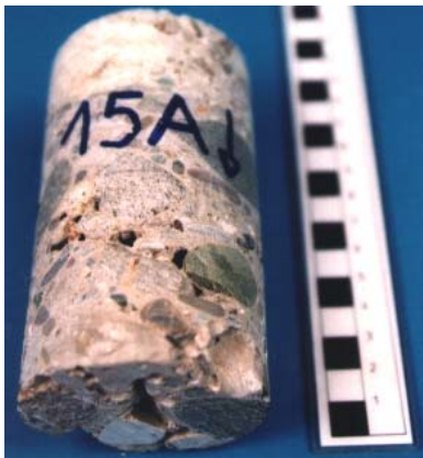
Abb 5: Untersuchter Bohrkern (Probe 1).
