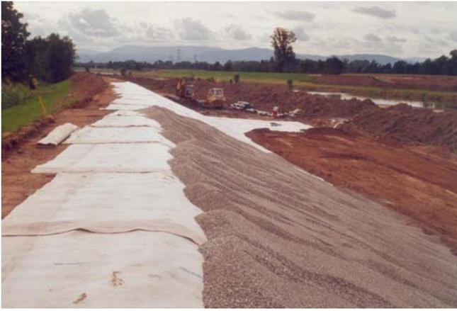
Bild 2: Deichertüchtigung an der Kinzig (2001): Überschütten der GTD mit Kiessand als "wühltierunfreundliche" Deckschicht (rechts)
