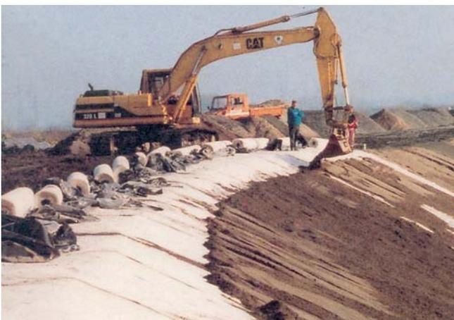
Bild 3: Lippedeich-Sanierung (1994): Einbau der GTD Bentofix als Deichdichtung (14)
